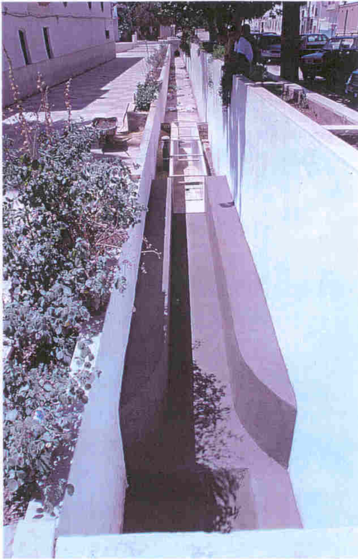
- Ojo de Gilena (Gilena). Arqueta, canal de aproximación y canal de aforo de 9".
