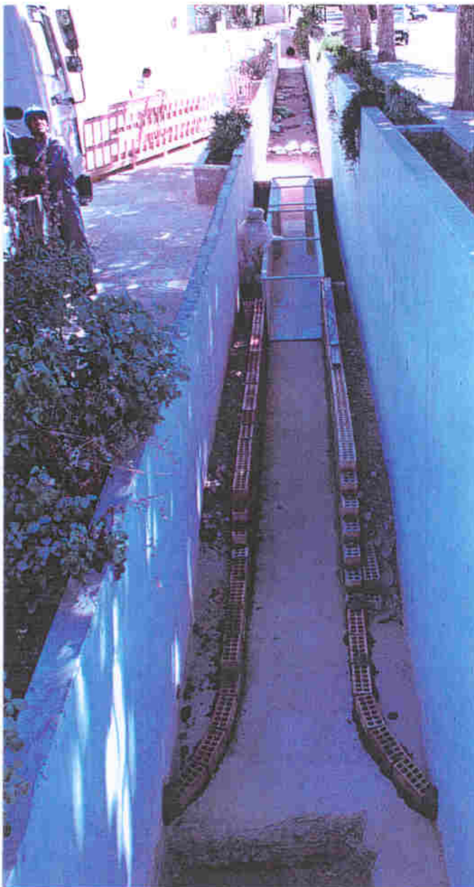
- Ojo de Gilena (Gilena). Construcción del canal de aproximación y canal de aforo de 9".
